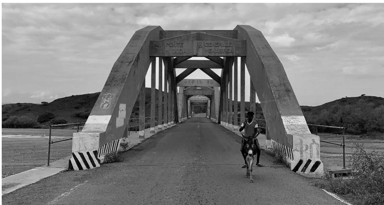
Ponte di Dogali
